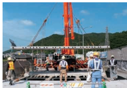
大規模修繕工事実施中(市川大橋)
